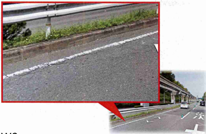
W3 舗装の補修箇所でマンホールが存在する
