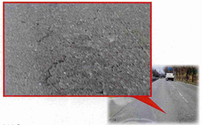
W2 万博周回道路に都心からの1号線が合流する箇所、渋滞で車両速度が低下して静荷重になった為と想定する
