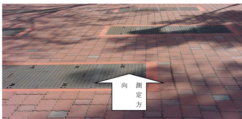
路面状況写真
